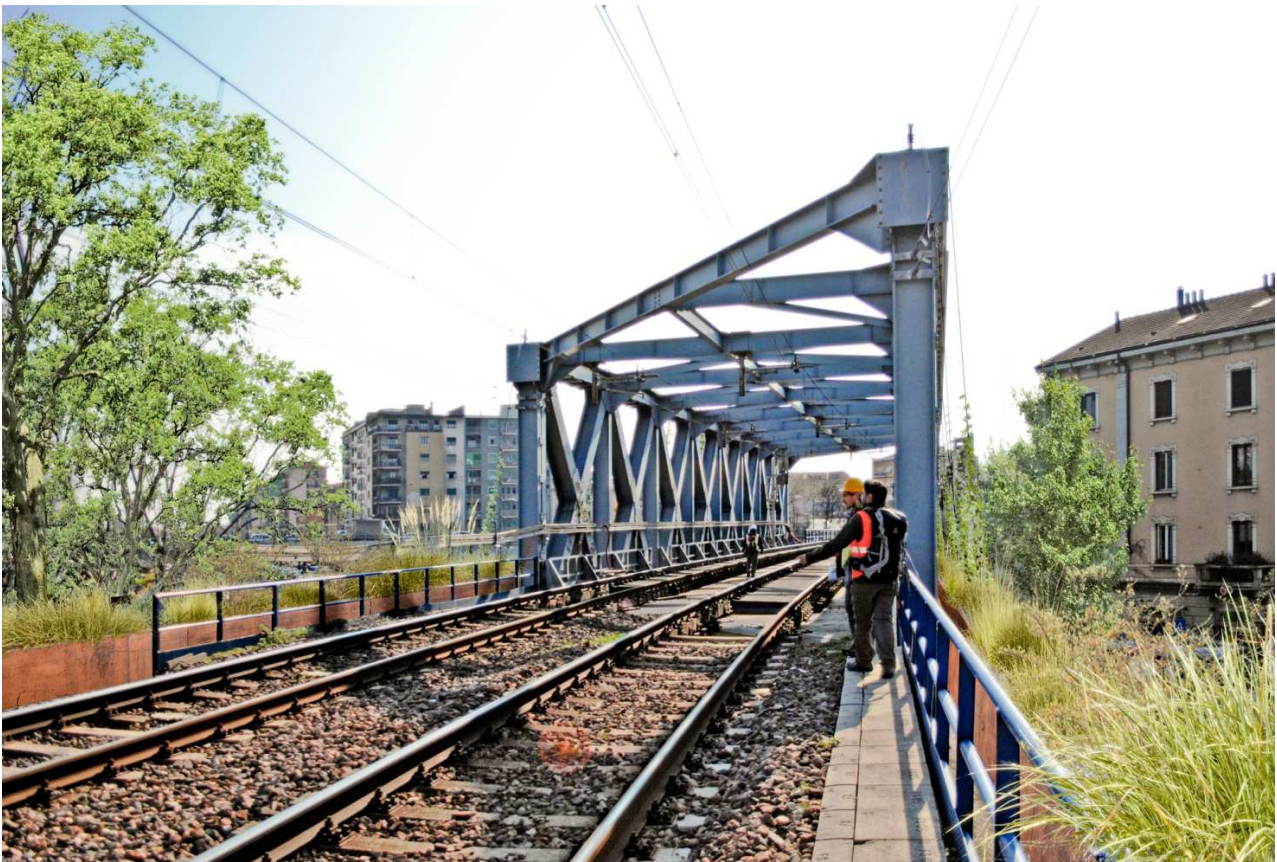
Figura 54. Ponte sul Naviglio Grande: rendering per l'ipotesi di passerelle o mensole laterali.
