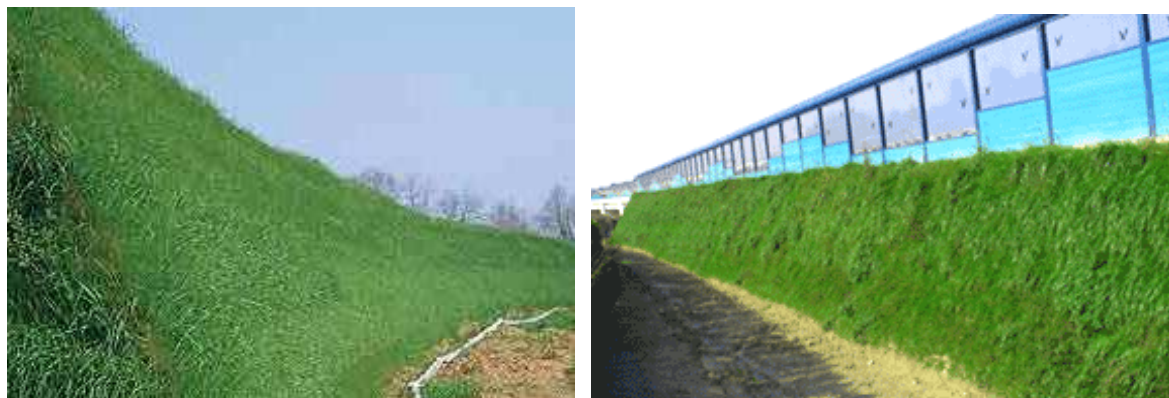
Figura 44. Esempi di barriere fonoprotettive inerbite poste a protezione della popolazione lungo arterie di elevata percorrenza ( http://www.tenax.net/geosintetici/rinforzo/barriere-fonoprotettive-inerbite.htm )
